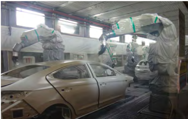
사람의 출입이 금지되는 도장공정에 설치된 컨베이어
