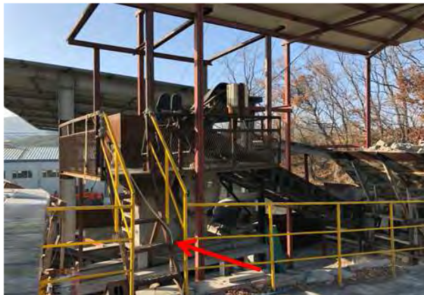
지상에 설치된 조작실 이동을 위해 계단 설치
